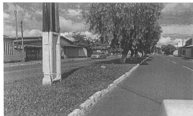
Figura 27 - Coordenadas Geográficas: 18°13'39.0"S 47°50'07.7"W - Avenida José Firmino - Data: 10/01/2022
