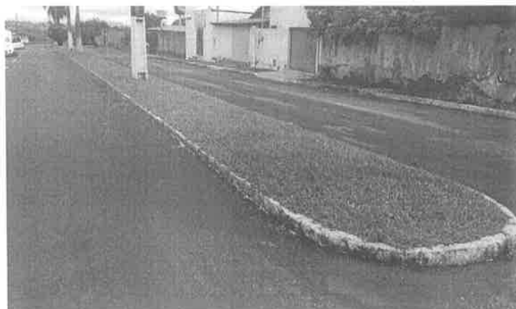
Figura 24 - Coordenadas Geográficas: 18°13'43.6"S 47°49'59.8"W - Avenida José Firmino - Data: 10/01/2022
