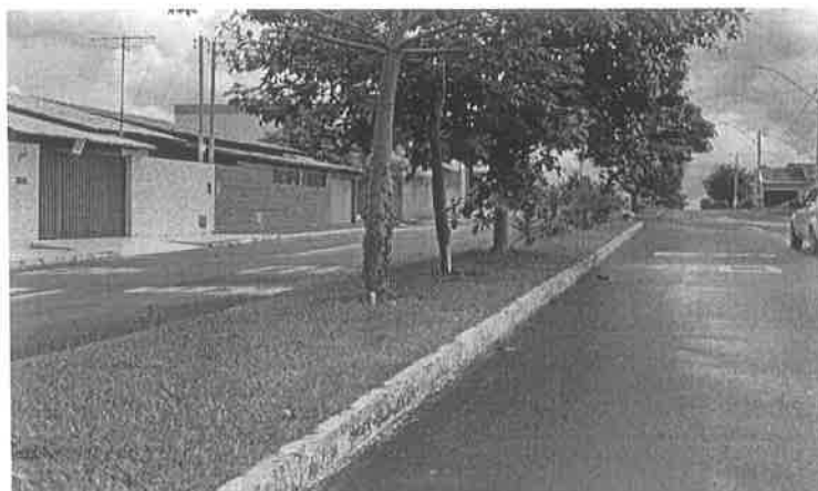
Figura 21 - Coordenadas Geográficas: 18^{\circ}14'09.2''S 47^{\circ}50'08.0''W - Avenida João Silvano Rosa - Data: 10/01/2022
