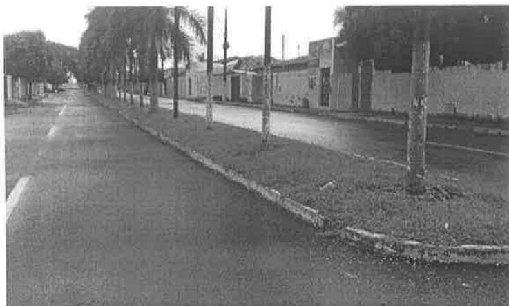
Figura 19 - Coordenadas Geográficas: 18^{\circ}13'58.6''S 47^{\circ}50'01.9''W - Avenida João Silvano Rosa - Data: 10/01/2022
