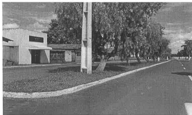
Figura 26 - Coordenadas Geográficas: 18°13'35.4"S 47°50'13.8"W - Avenida José Firmino - Data: 10/01/2022
