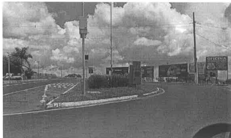
Figura 17 - Coordenadas Geográficas: 18^{\circ}14'17.3''S 47^{\circ}50'40.4''W - Trevo de acesso a cidade - Data: 10/01/2022
