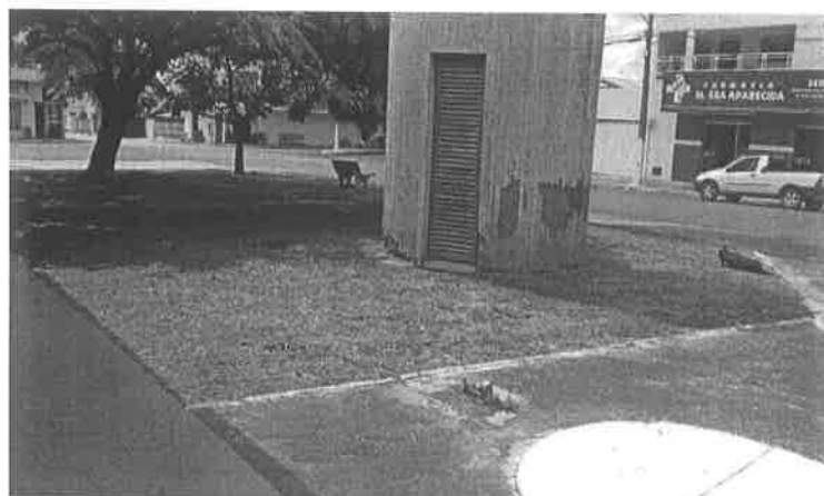
Figura 45 - Coordenadas Geográficas: 18^{\circ}13'59.5''S 47^{\circ}50'09.3''W - Praça da Rodoviária - Data: 10/01/2022
