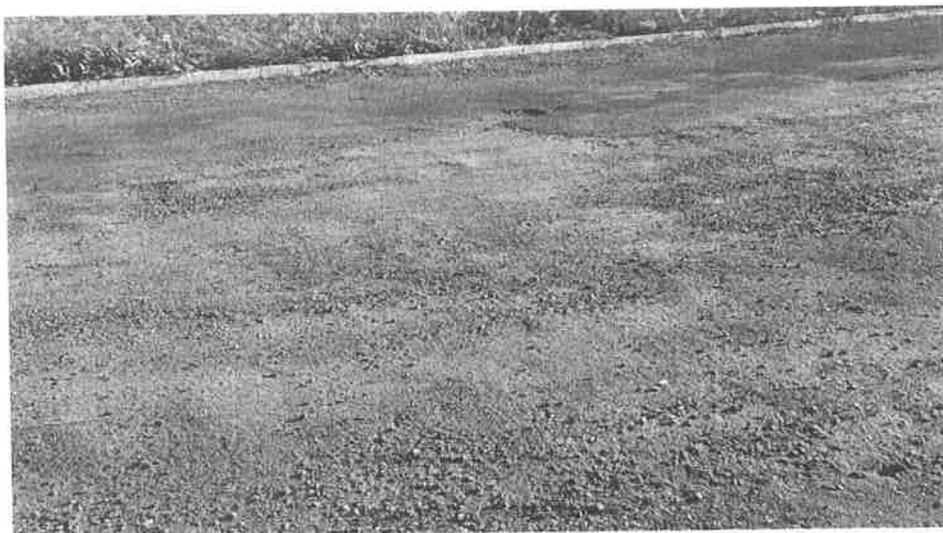
Figura 3 - Pavimento asfáltico existente, apresentando imperfeições que justificam os serviços de correção de defeitos através de camada de nivelamento em massa asfáltica CBUQ em toda a largura das ruas, no bairro Jardim JK, município de Ouvidor - Goiás.
