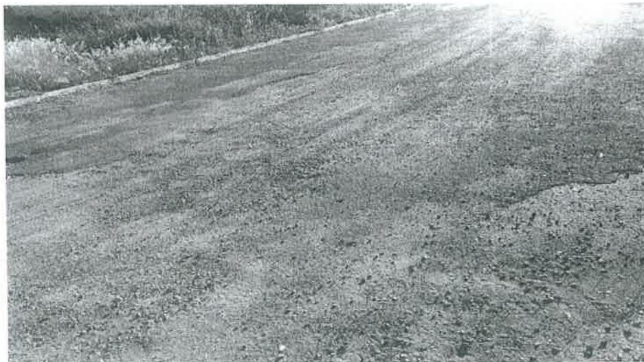
Figura 2 - Pavimento asfáltico existente, apresentando imperfeições que justificam os serviços de correção de defeitos através de camada de nivelamento em massa asfáltica CBUQ em toda a largura das ruas, no bairro Jardim JK, município de Ouvidor - Goiás.
