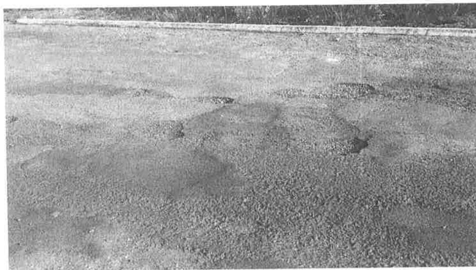
Figura 4 - Pavimento asfáltico existente, apresentando imperfeições que justificam os serviços de correção de defeitos através de camada de nivelamento em massa asfáltica CBUQ em toda a largura das ruas, no bairro Jardim JK, município de Ouvidor - Goiás.
