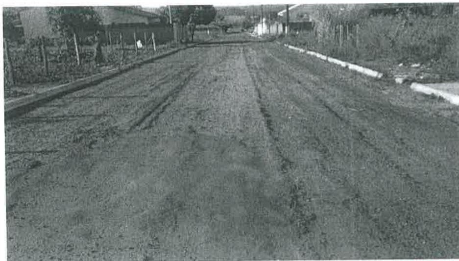
Figura 6 - Pavimento asfáltico existente, apresentando imperfeições que justificam os serviços de correção de defeitos através de camada de nivelamento em massa asfáltica CBUQ em toda a largura das ruas, no bairro Jardim JK, município de Ouvidor - Goiás.
