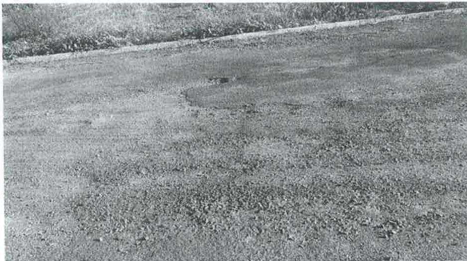
Figura 1 - Pavimento asfáltico existente, apresentando imperfeições que justificam os serviços de correção de defeitos através de camada de nivelamento em massa asfáltica CBUQ em toda a largura das ruas, no bairro Jardim JK, município de Ouvidor - Goiás.
