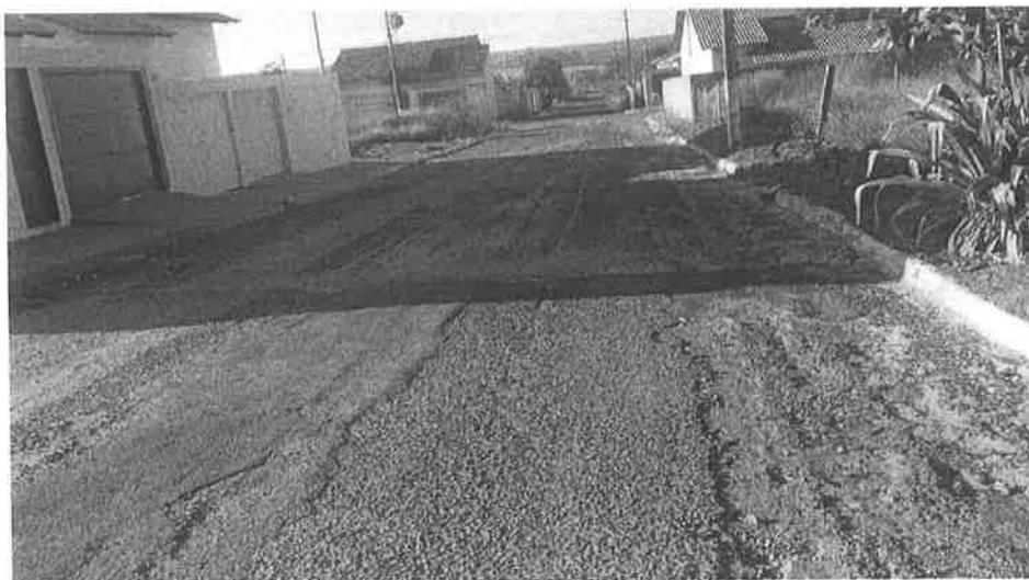
Figura 7 - Pavimento asfáltico existente, apresentando imperfeições que justificam os serviços de correção de defeitos através de camada de nivelamento em massa asfáltica CBUQ em toda a largura das ruas, no bairro Jardim JK, município de Ouvidor - Goiás.
