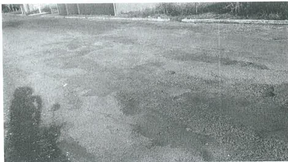
Figura 5 - Pavimento asfáltico existente, apresentando imperfeições que justificam os serviços de correção de defeitos através de camada de nivelamento em massa asfáltica CBUQ em toda a largura das ruas, no bairro Jardim JK, município de Ouvidor - Goiás.
