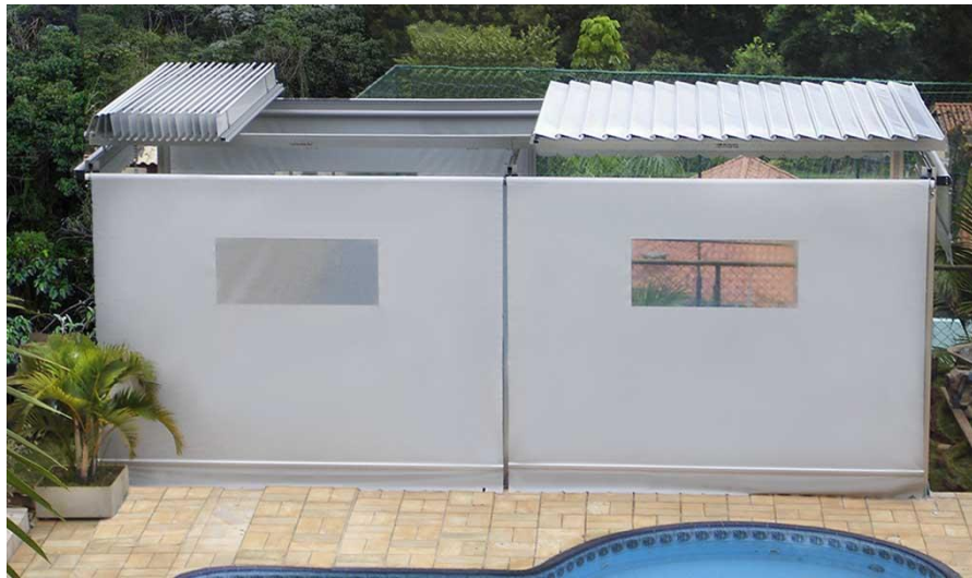
Figura 11: Imagem que ilustra o modelo de cobertura retrátil para pátio de refeições.
